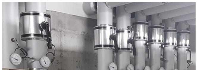
**[ABB. 12]** Die leicht zu demontierenden Armaturenkappen sind wenn möglich auf die Rohrdämmung abzustellen.
