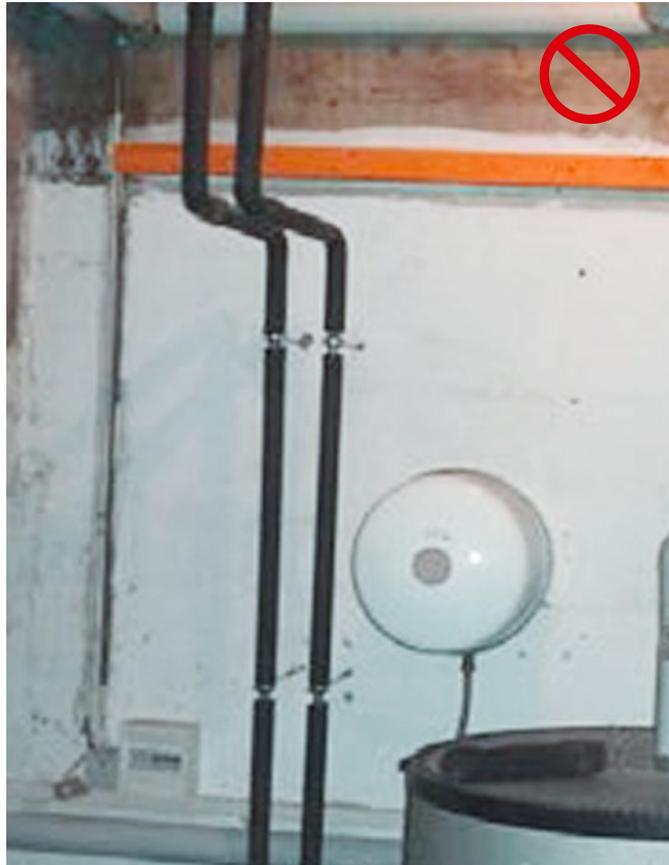
**[ABB. 36]** Hier geht viel Wärme verloren: lange Rohrleitungsführung im unbeheizten Innenraum. Lückenhaftes, stellenweise nicht fachmännisch angebrachtes elastomeres Dämmmaterial mit zu geringer Dämmstärke (ca. 13 mm), direkte Verbindung der ungedämmten Rohrleitung zur Halterung (Wärmebrücke!).
