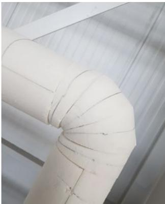
**[ABB. 10]** Bogendämmung aus segmentgeschnittenen PIR-Halbschalen.
