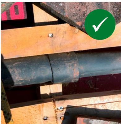
**[ABB. 34]** Hier wurde die Konterlattung ausgespart und die Rohrleitung durchgehend gedämmt.
