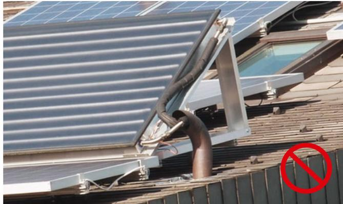
**[ABB. 39]** Das Dämmmaterial sackt nach unten ab. Es besteht die Gefahr, dass Regenwasser in das Umhüllungsrohr eintritt und ins Gebäudeinnere gelangt. Anschlüsse am Kollektor sind nicht gedämmt, Fühlerkabel ist verknäuelnd und der UV-Strahlung ausgesetzt.
