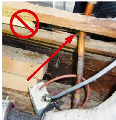
**[ABB. 33]** Holz in Kontakt mit heissen Rohrleitungen.
