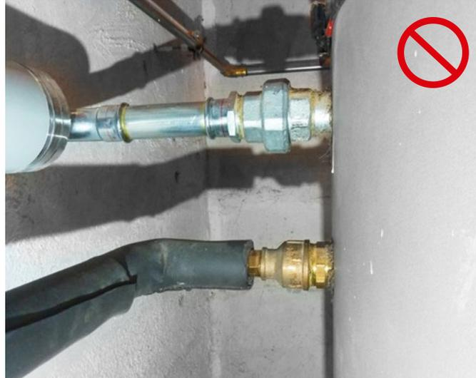
**[ABB. 31]** Diese Installation zeigt mehrere Nachlässigkeiten gleichzeitig auf: Die Anschlüsse am Warmwasserspeicher sind nicht gedämmt. Die Dämmstärke des synthetischen Kautschuks entspricht nicht den Vorschriften. Die Naht ist nicht richtig verschlossen und sie sollte nicht seitlich, sondern zur Verhinderung der natürlichen Konvektion bevorzugt im unteren Bereich angeordnet sein. An diese Rohrleitung gehört eine klassische Dämmung mit Mineralwolle gemäss kantonalen Energiegesetzen!
