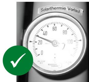
**[ABB. 40]** Thermometer mit geeigneter Abstandshülse verwenden.
