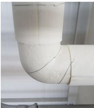
**[ABB. 9]** Dämmung aus geschäumten oder aus blockgeschnittenen Fertigbogen.
