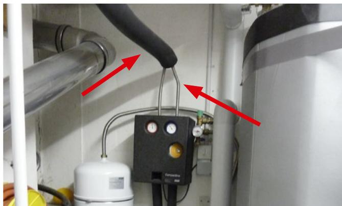
**[ABB. 41]** Dämmung bis in die Solarstation hineinführen.
